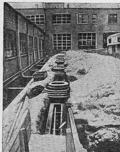
В таком состоянии сильные декабрьские морозы застала строительная площадка на пароподогреву двигателей в 3-м автобусном парке
